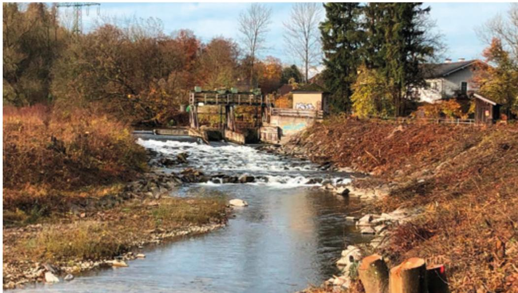
Hier sieht man den gerodeten Abschnitt unterhalb der alten Wehranlage. Die Energie AG errichtet an dieser Stelle das neue Kraftwerk mit Wehranlage. Anschließend wird der alte Werkskanal und das alte Kraftwerk außer Betrieb genommen. Der alte Werkskanal wird mit Abraum befüllt und ist dann Geschichte.
